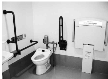
1階多目的トイレ
