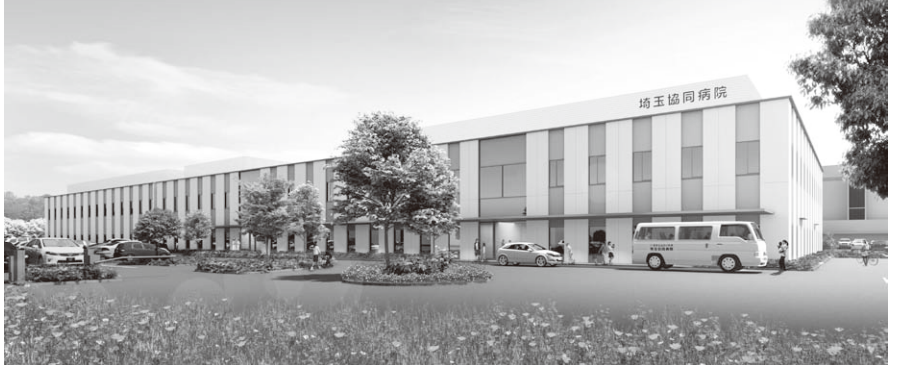
第2病院(仮称)外観
